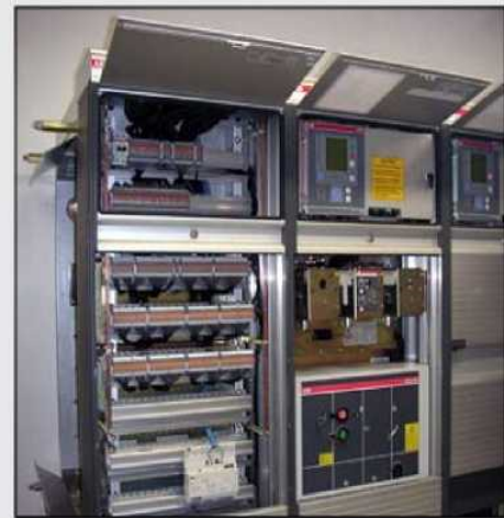
Switchgear
